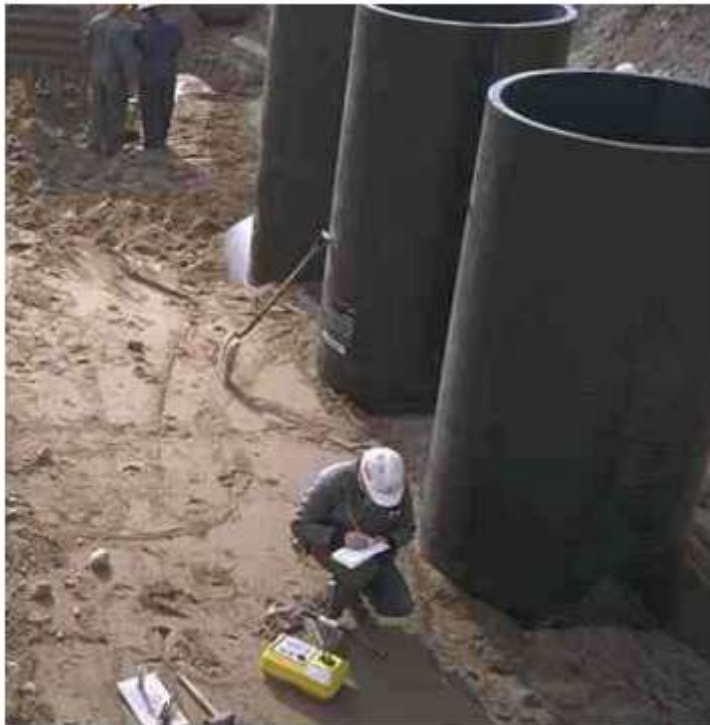
شکل ۵: انجام آزمایش تراکم خاک
