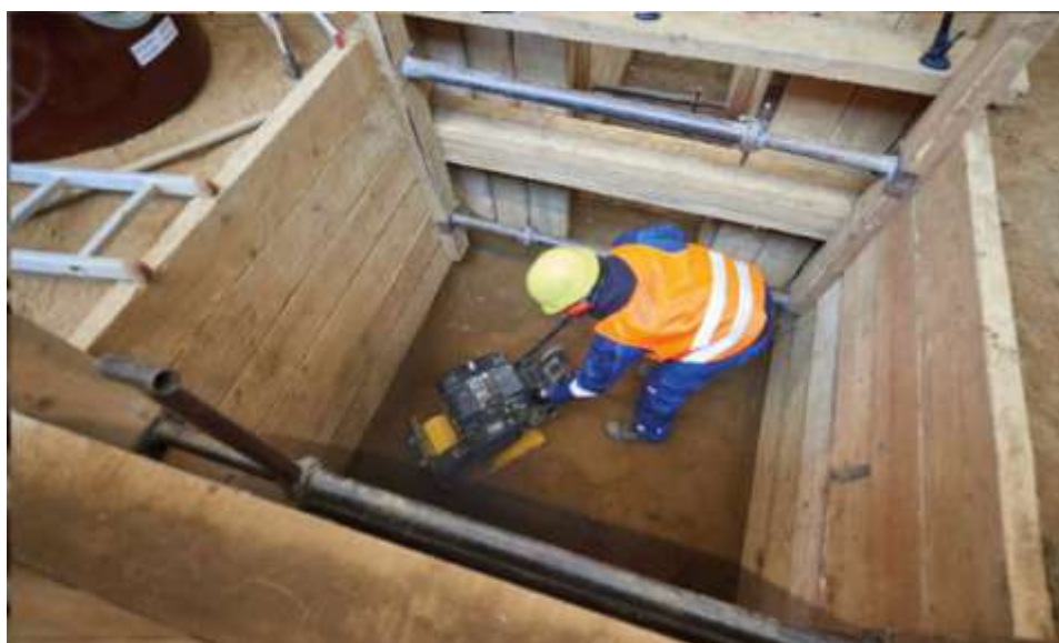
شکل ۴: عملیات متراکم سازی و تراز فونداسیون
