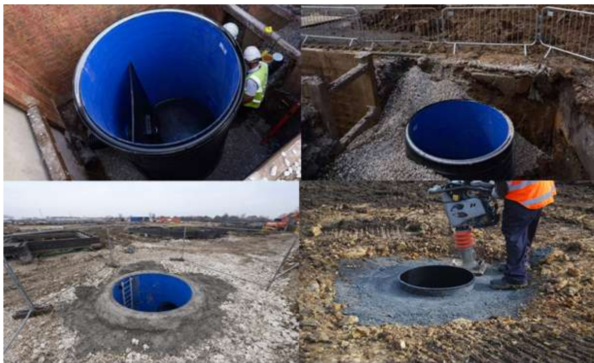
شکل ۶: عملیات خاکریزی و متراکم سازی مصالح پرکننده
