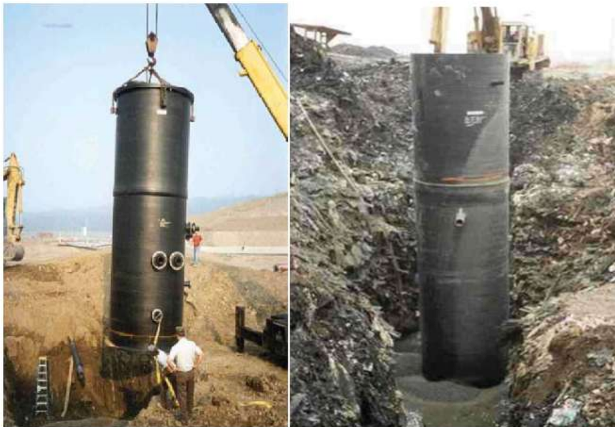
شکل ۲: نحوه ی بلند کردن صحیح منهول و جایگذاری در داخل ترانشه
