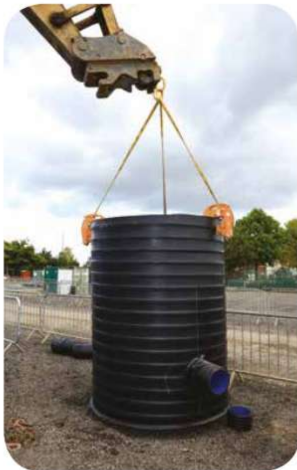
شکل ۱: نحوه ی استفاده از تسمه و قلاب ها برای بلند کردن منهول
