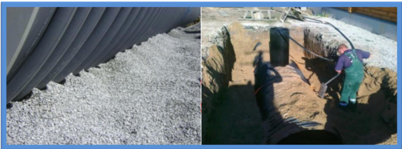
بزرگترین تامین کننده تجهیزات و مجری پروژه های عمرانی شکل ۴: نمونه ای از پر کردن اطراف مخزن
